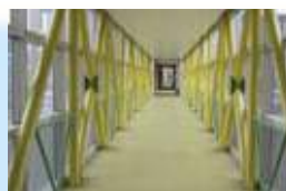
↑ ⑦ 渡り廊下
